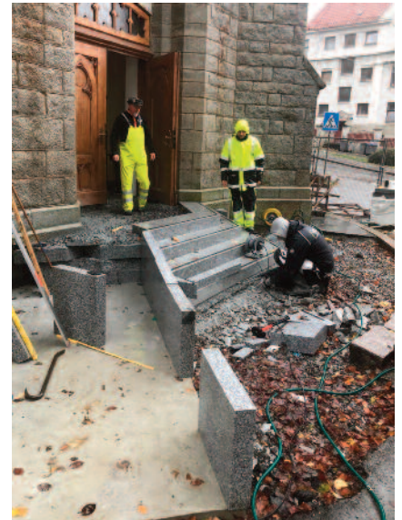
Det jobbes med ny adkomst for rullestoler og barnevogner ved hovedinngangen til Sandvikskirken. Den er lovet å være ferdig til jul!
